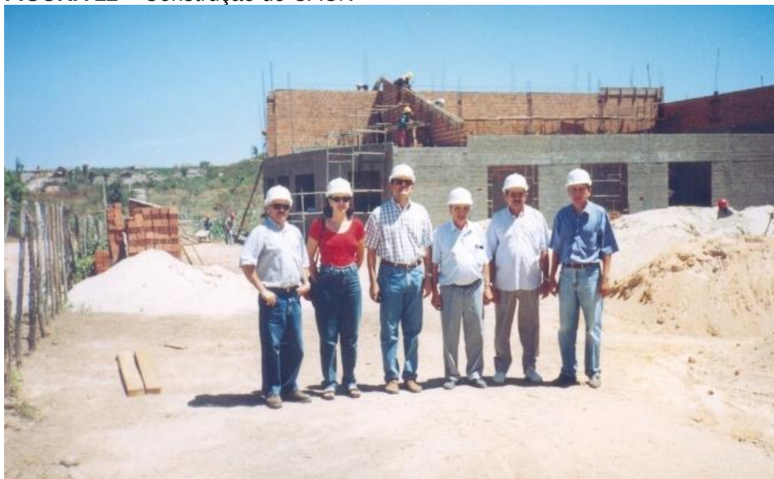
FIGURA 12 – Construção do CACN
