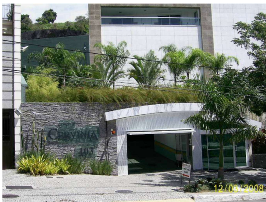
Figura 21 – Telhado verde intensivo
