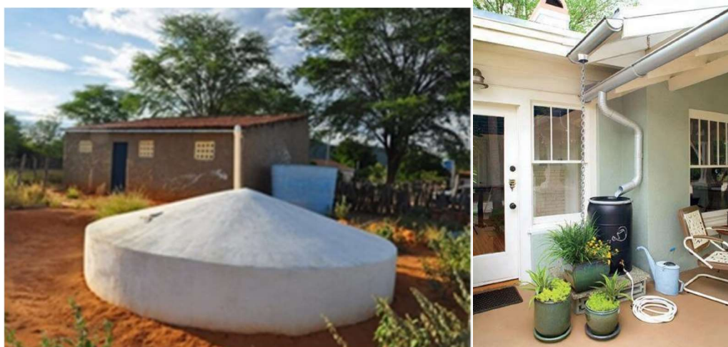
Figura 6 – microrreservatórios de águas pluviais
