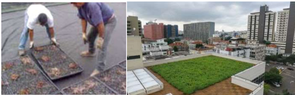
Figura 8 – Telhado Verde em laje
