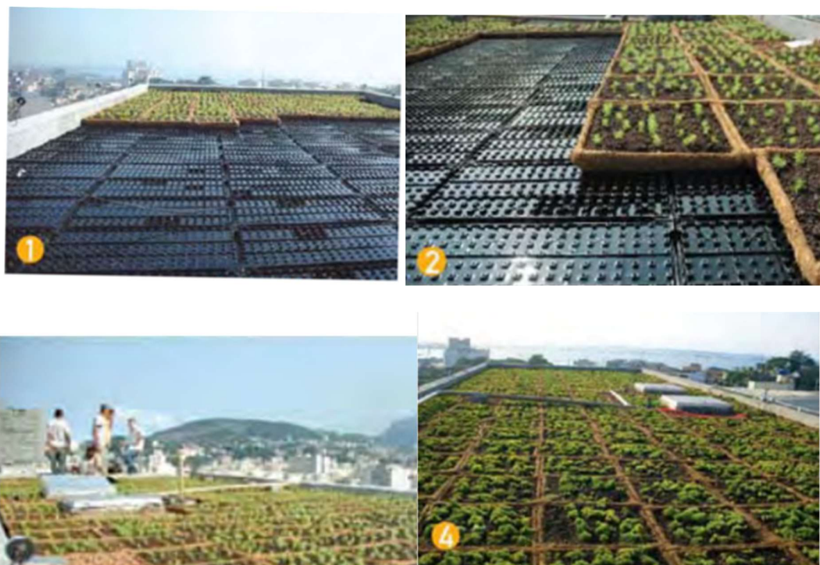
Figura 22 – Etapas de montagem do biotelhado Premium
