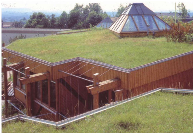
Figura 20 – telhado verde extensivo
