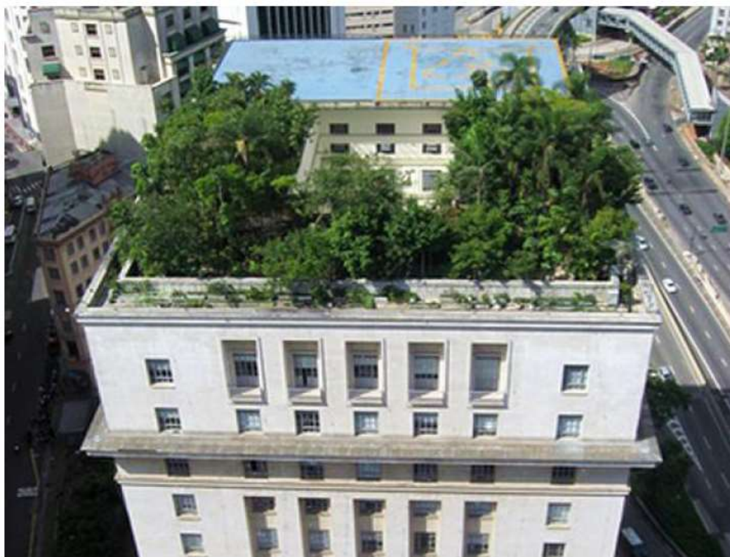
Figura 19 – Telhado Verde Intensivo
