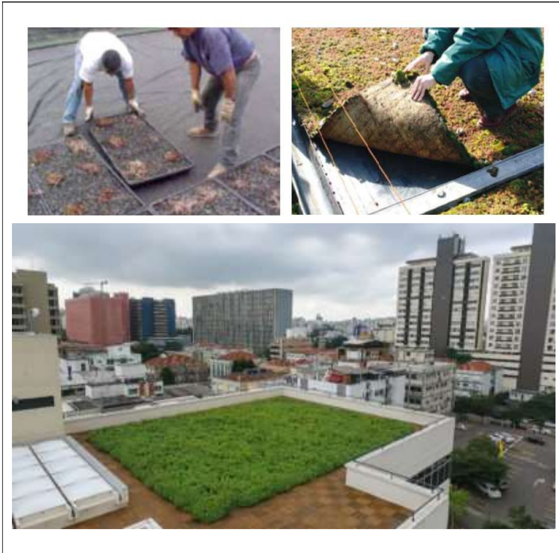
Figura 18 – Telhado Verde Extensivo
