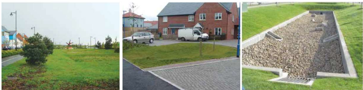
Figura 21 – Bacias de infiltração ou percolação
