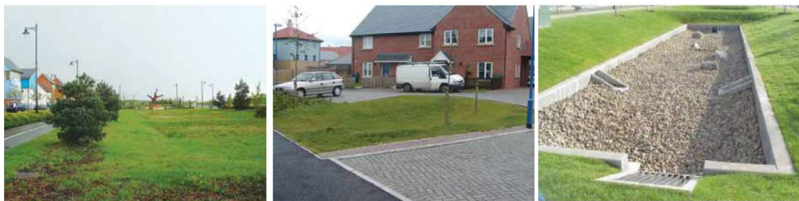
Figura 13 – Bacias de infiltração ou percolação
