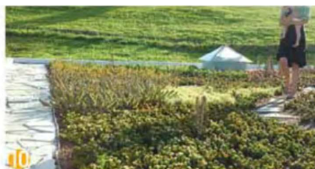
Figura 25 – Montagem do sistema modular biotelhado
