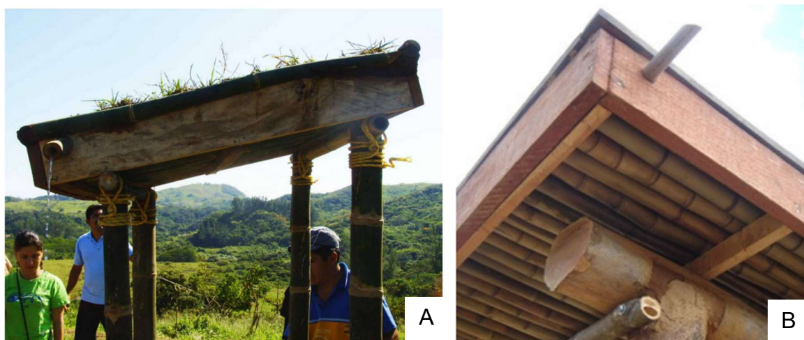
Figura 28 – Telhado verde com estrutura de madeira e bambu
