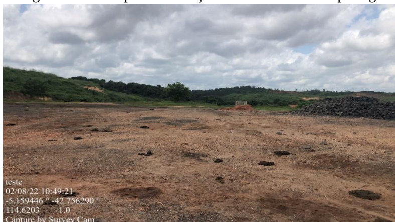
Figura 19 – Área para construção da Unidade de Compostagem
