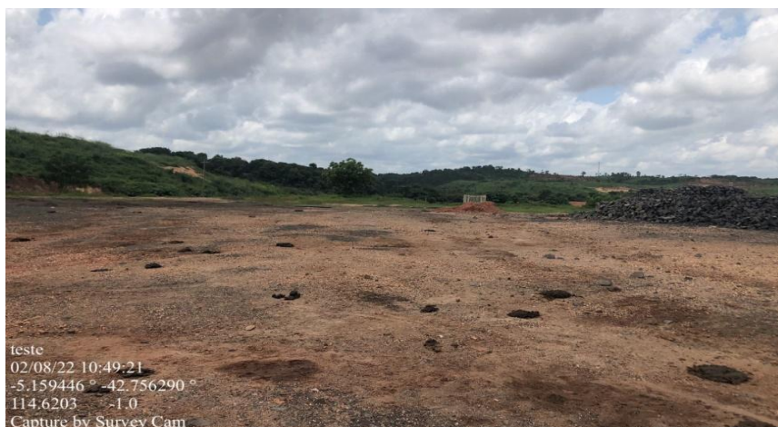
Figura 8 – Área para construção da Unidade de Compostagem.
