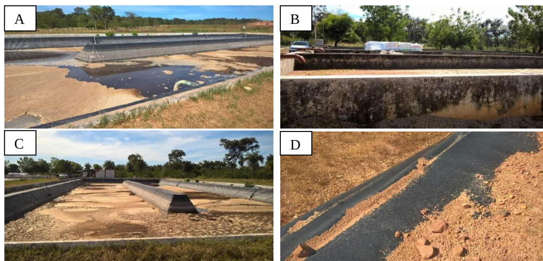
Figura 6 – Pannel de fotos do Tanque de tratamento do chorume no Aterro Sanitário em construção.
