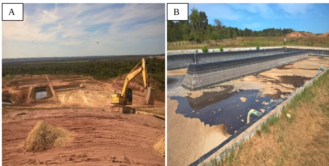
Figura 3 – Aterro Sanitário em construção.
