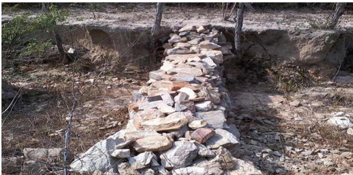
Figura 2. Represa com estruturas de pedras. Fonte: INSA, 2014.
