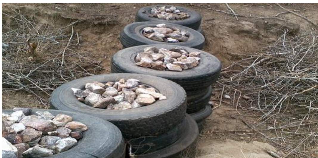
Figura 4. Detalhe de uma barreira de pneus cheios com pedras.
