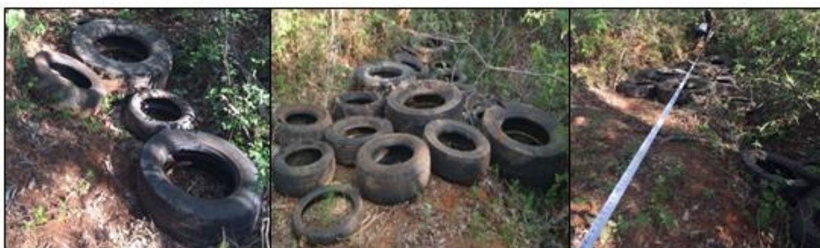
Figura 12. Técnica de utilização de pneus no preenchimento de voçoroca.
