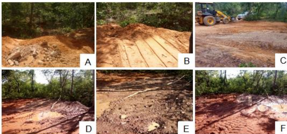
Figura 14. Processo de aterramento da voçoroca.
