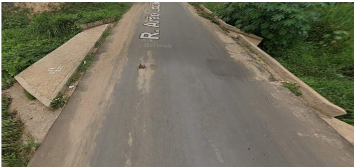
Figura 14 – Passagem sobre o Córrego dos Barreiros
