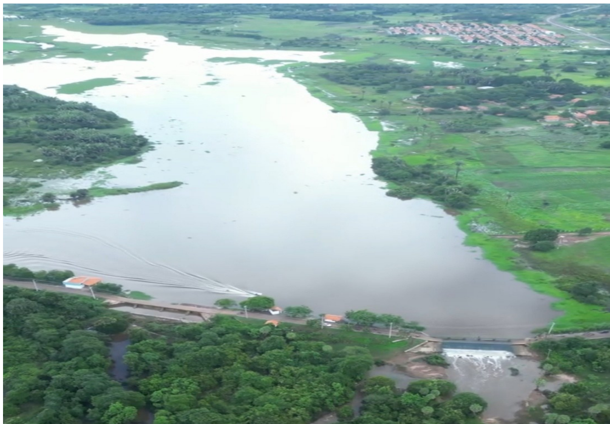
Figura 13 – Barragem Filinto Rêgo
