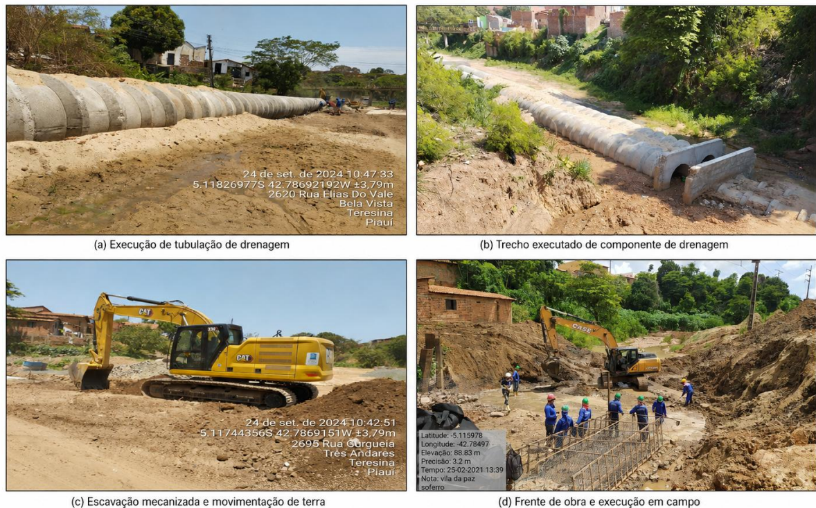
Figura 6 – Registros documentais da execução parcial dos componentes de drenagem na 2ª etapa da Vila da Paz
