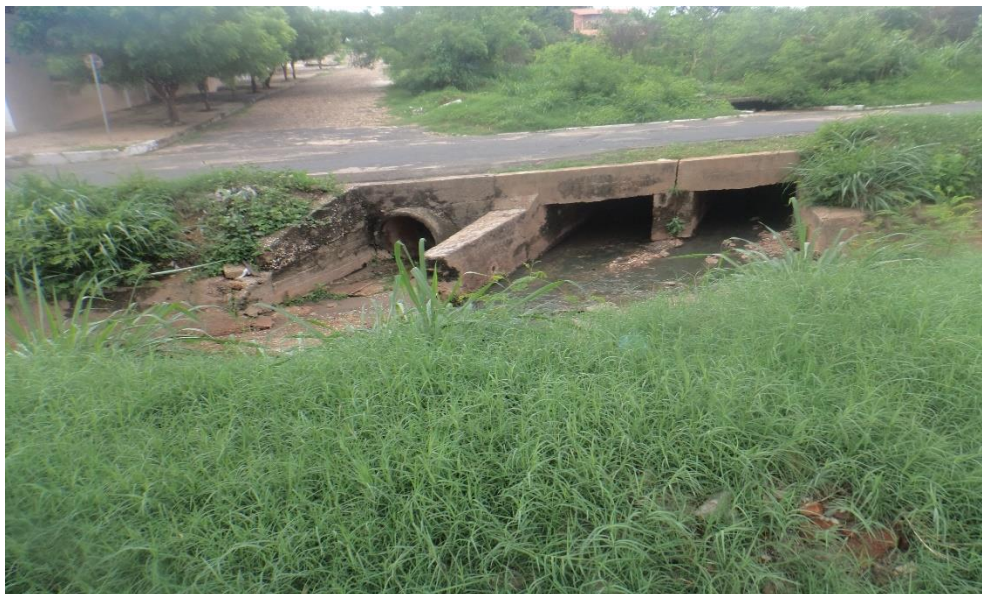
Foto 4 – Galeria e rede de esgoto encontrada
