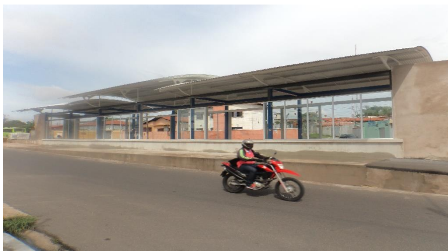
Foto 2- Estação de ônibus sendo instalada.
