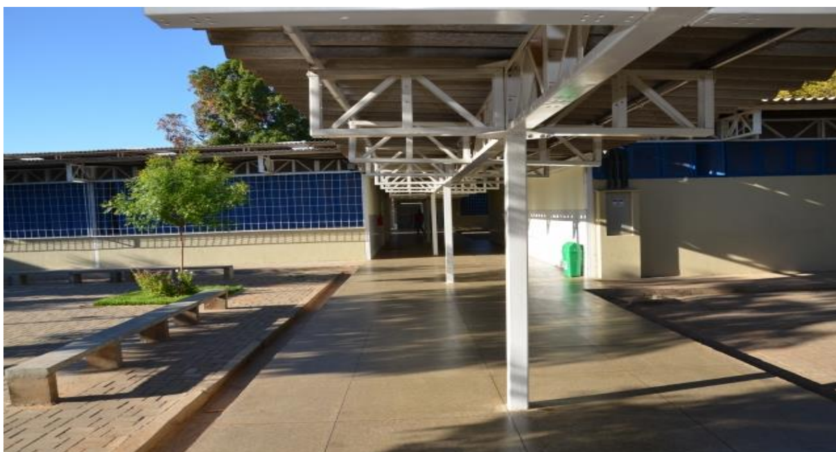
Figura 03: Registros da estrutura interna do Centro Estadual de Educação Profissional Petrônio Portela.
