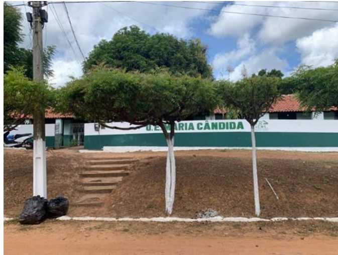
Figura 02: Faixada da Unidade Escolar Maria Cândida.
