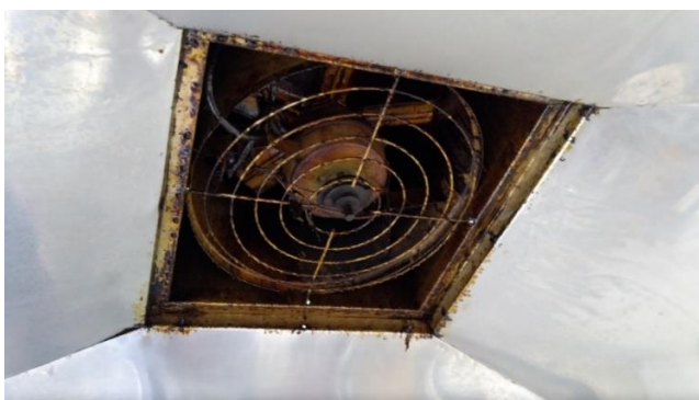
Figura 16 - Exaustor axial na entrada da coifa 1
