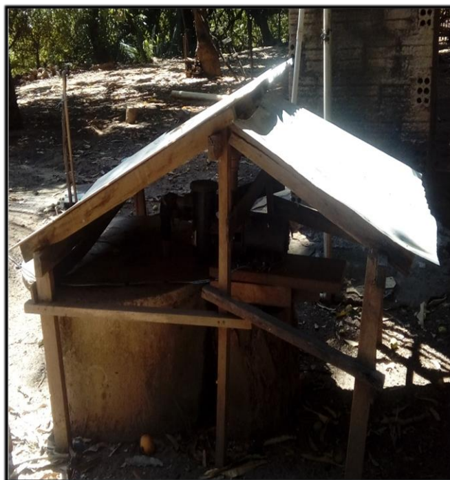
Figura 31: Fotografia da casa de proteção do poço feita de madeira e telhas.
