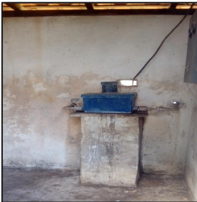
Figura 33: Fotografia do dosador de cloro
