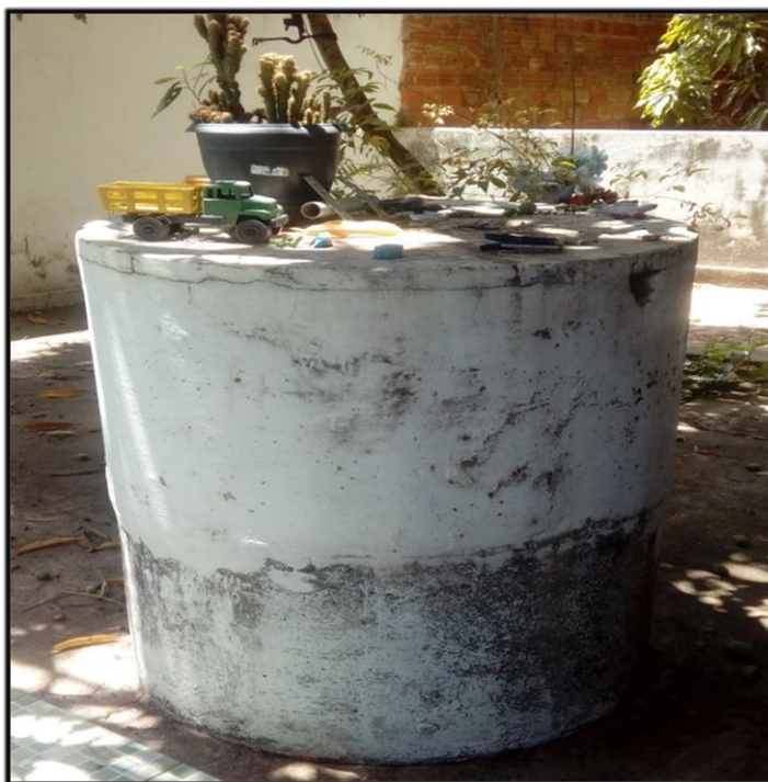
Figura 27: Fotografia de um poço vedado com tampa de concreto armado.
