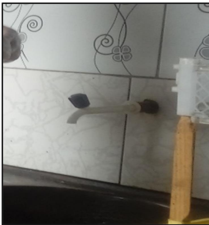
Figura 13: Fotografia da torneira usada para coletar a amostra da rede de distribuição do poço tubular da Alegria.
