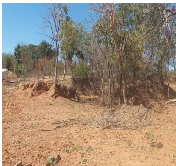
Figura 1. Desmatamento da área da barragem de Cocos.
