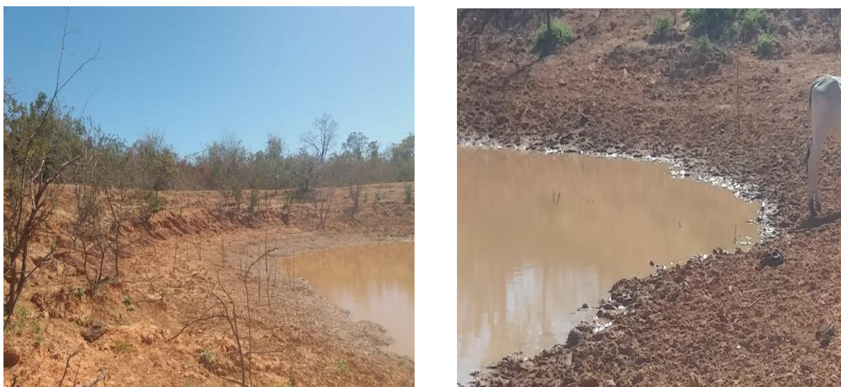
Figura 2- Compactação do solo da barragem de Cocos.
