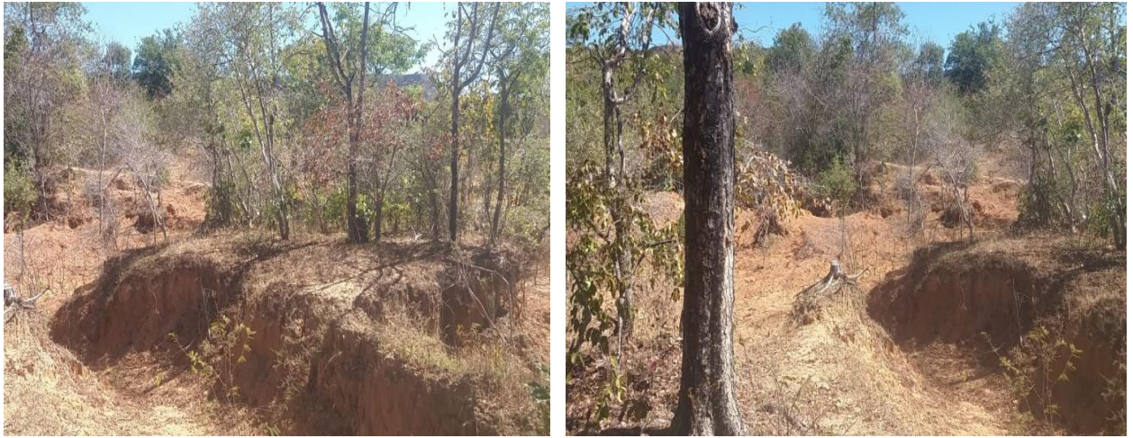
Figura 4. Voçorocas da barragem dos Cocos.
