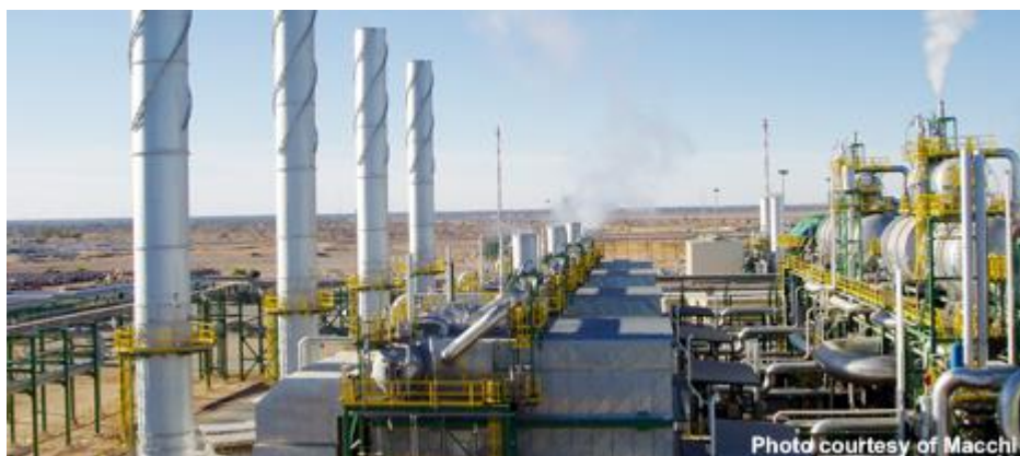
Figura 1. Termelétrica a gás natural de ciclo aberto.
