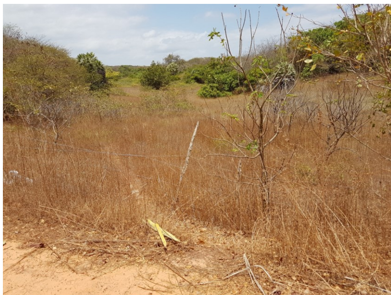
Figura 14- Estrada que dá acesso a lagoa do Portinho à Br 402, ponto onde a estrada obstrui a passagem de água do curso d'água. Ponto correspondente às coordenadas 02° 56'22.66" S/41°41'23,23"O.
