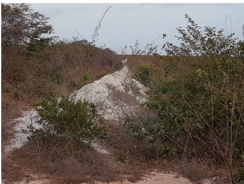
Figura 13- Local de escavação de canal para irrigação inacabado, com sedimentos expostos à ação do vento e da chuva. Ponto correspondente às coordenadas 03°06'18,82"S/ 41°44'12,68"O.
