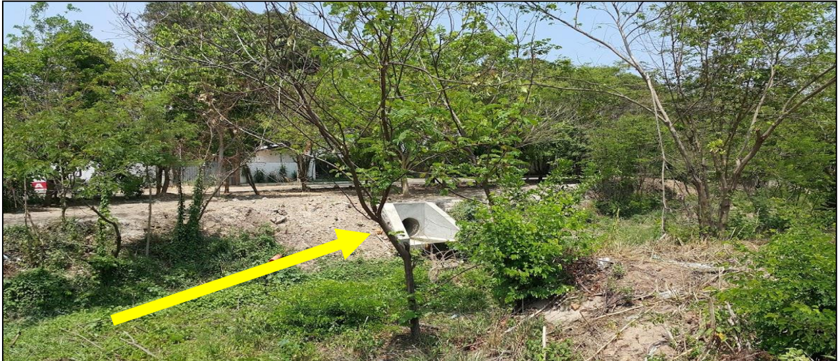
Figura 14: Margem do córrego e galeria de esgoto ao fundo
