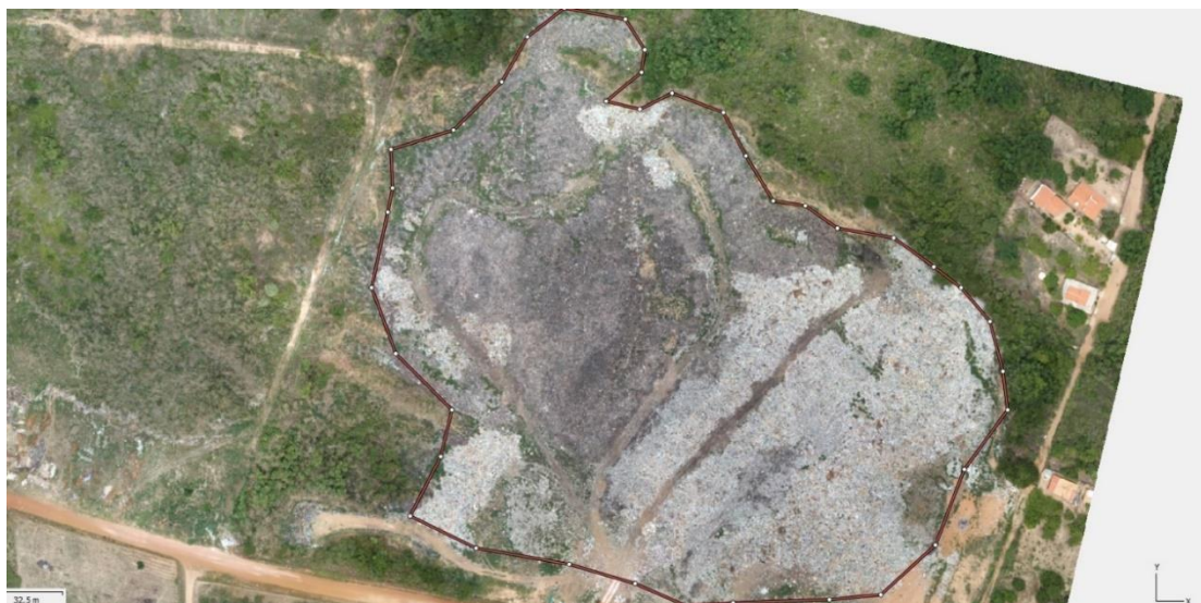
Figura 20: Área que os resíduos ocupam
