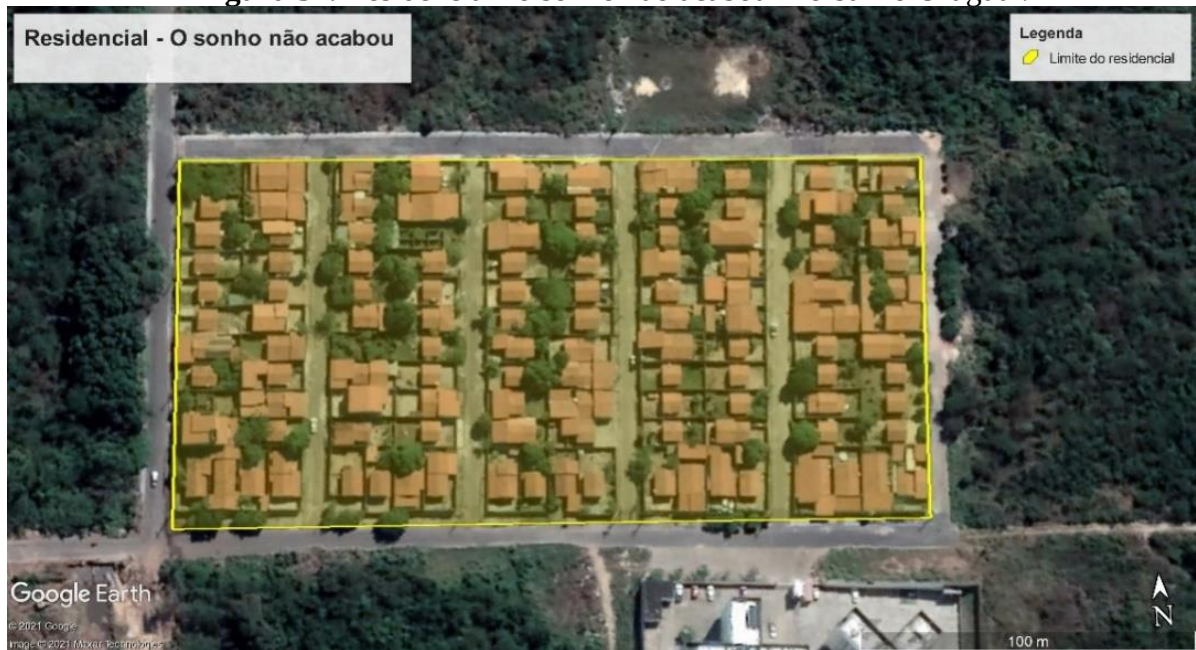
Figura 34. Residencial “o sonho não acabou” no bairro Uruguai.
