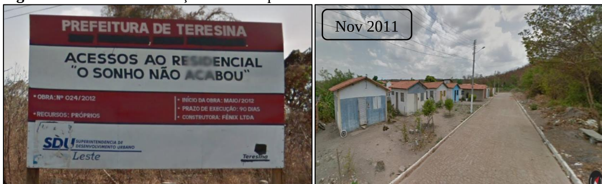
Figura 33. Placa de construção e rua da quadra L do Residencial “o sonho não acabou”.
