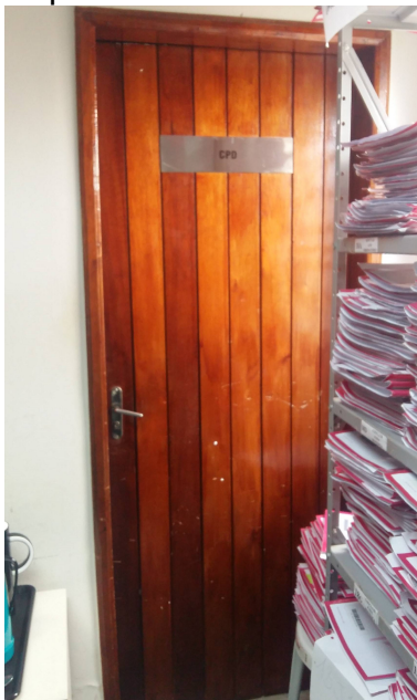
Figura 20: porta de acesso ao data center
