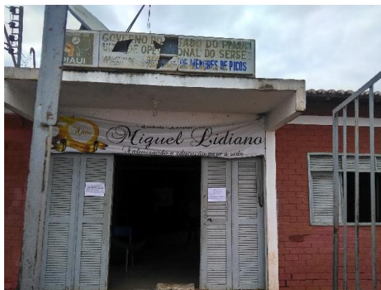
Figura 2: Fachada da Unidade Escolar Miguel Lidiano
