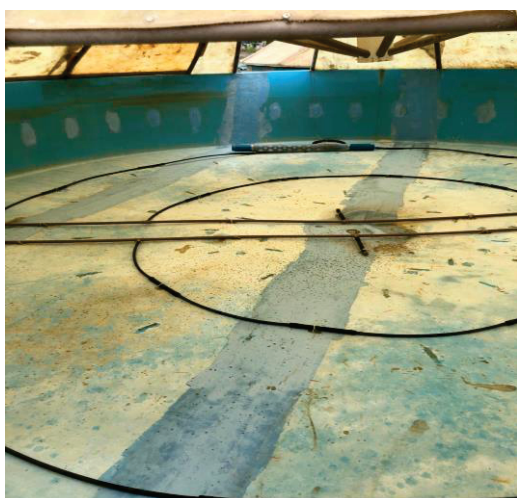
Figura 17: Sistema aeração de um tanque berçário
