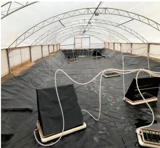
Figura 13: Sistema de Aeração
