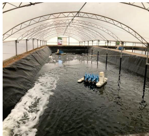
Figura 14: Tanque com sistema de aeração
