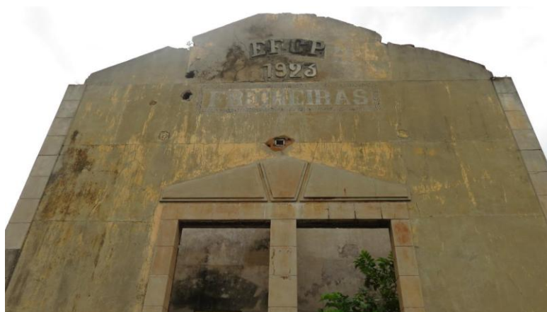
Figura 01: Antiga Estação Ferroviária de Frecheira de São Pedro, Cocal-PI. Fonte: Autor, 2019.
