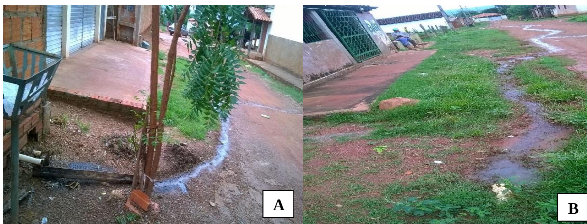
Figura 2 -A e B : Esgoto lançado a céu aberto no bairro vermelhão. Fonte: Autora 2017
