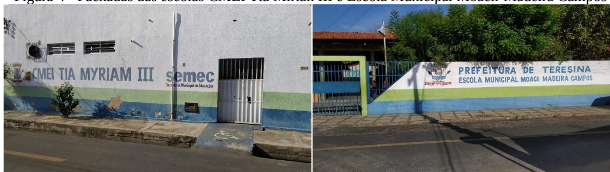
Figura 4 - Fachadas das escolas CMEI Tia Mirian III e Escola Municipal Moacir Madeira Campos
