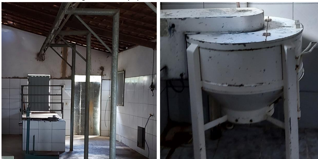
Figura 10: Equipamentos do abatedouro.
