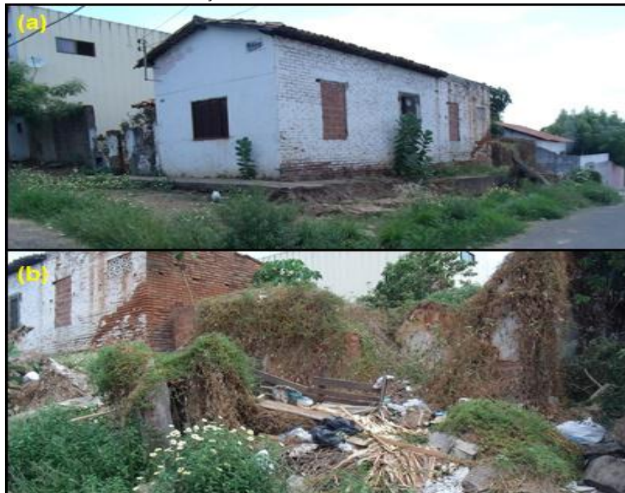
FIGURA 4- SITUAÇÃO DE ÁREA INSALUBRE PARA MORADIA
