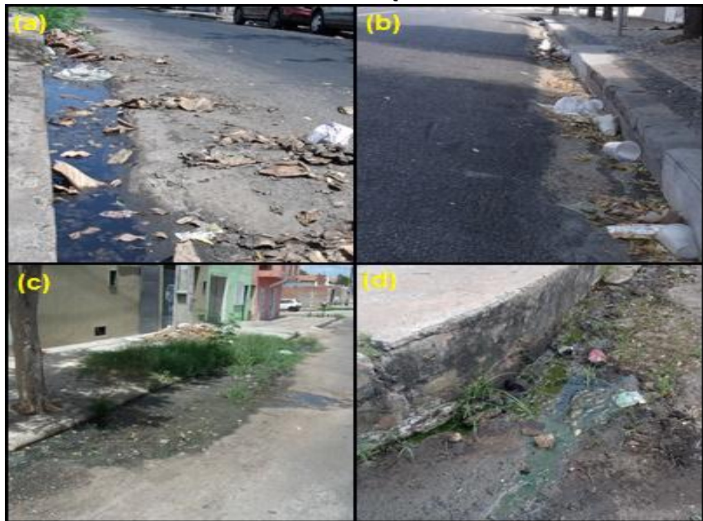
FIGURA 6- DESCARTE INADEQUADO DE RESÍDUOS
