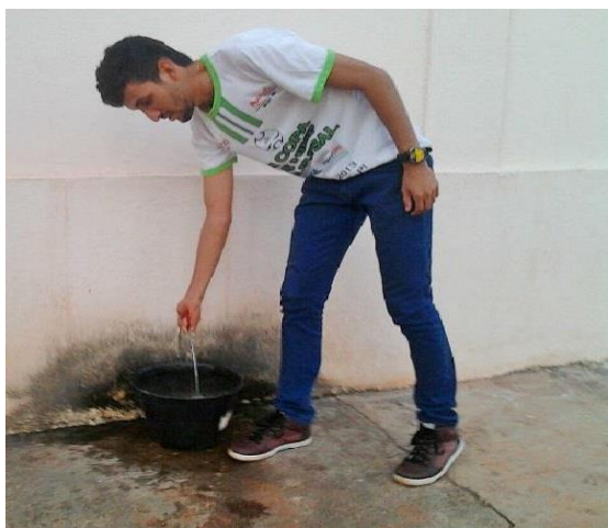
Figura 4 -Vazamento de água de aparelho de ar. Fonte: Produção original, 2017.
