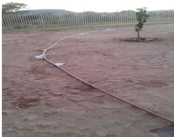
Figura 12: Mangueira com vazamentos Fonte: Produção original, 2016.
