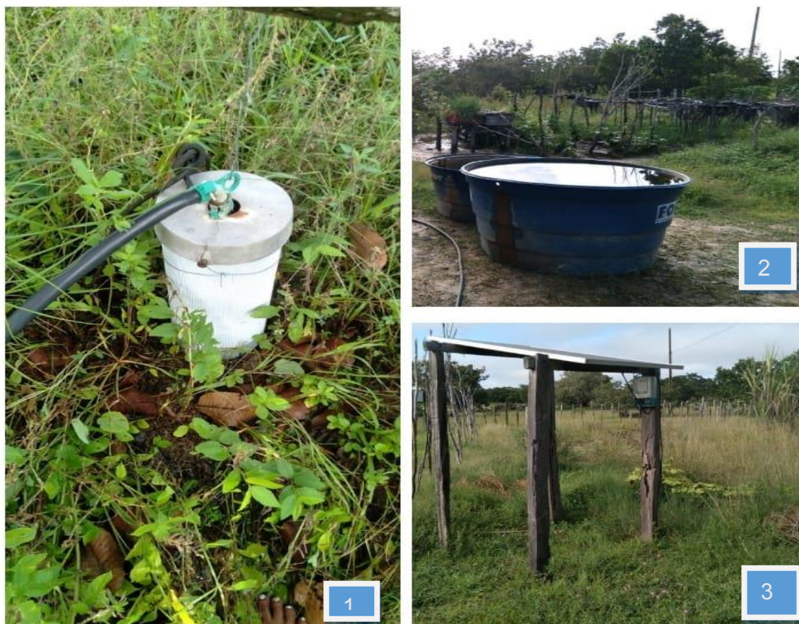
Figura 18 – Registro dos equipamentos para geração da produtividade no Assentamento Marcos em José de Freitas-PI: (1) motobomba; (2) reservatório para reserva da água; (3) Painele Fotovoltaico
