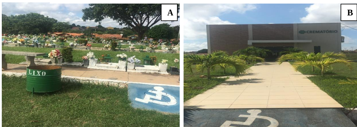
Figura 32. A - Rampa de acessibilidade à área de sepultamentos; B - Rampa de acessibilidade ao Crematório do Cemitério Jardim da Ressurreição, Zona Sudeste, Teresina
