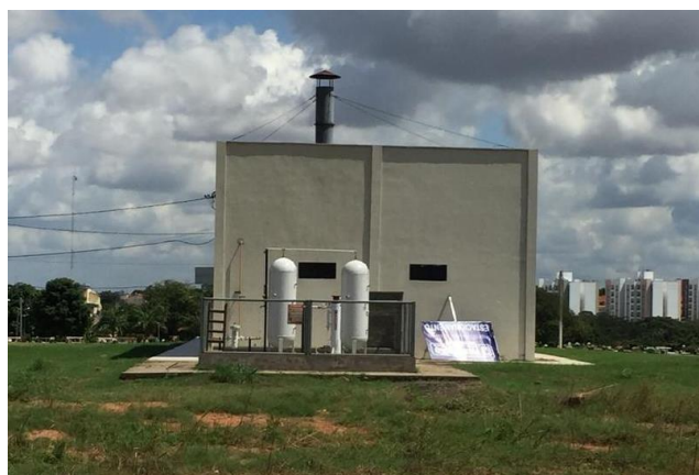
Figura 34. Chaminé e cilindros com monóxido de carbono do Crematório Jardim da Ressurreição, Zona Sudeste, Teresina
