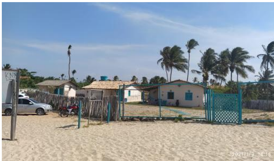
Figura 14: A – Bares dentro do mar e B - Casas e cerca de metal na linha de praia (Ponto 11). Fonte: Autores, 2021.
