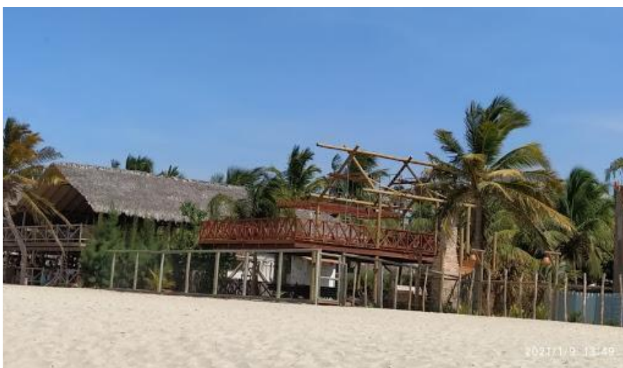
Figura 12: A – Empreendimento em funcionamento na linha de praia e B - Construção avançada no limite da linha de praia (Ponto 9). Fonte: Autores, 2021.
