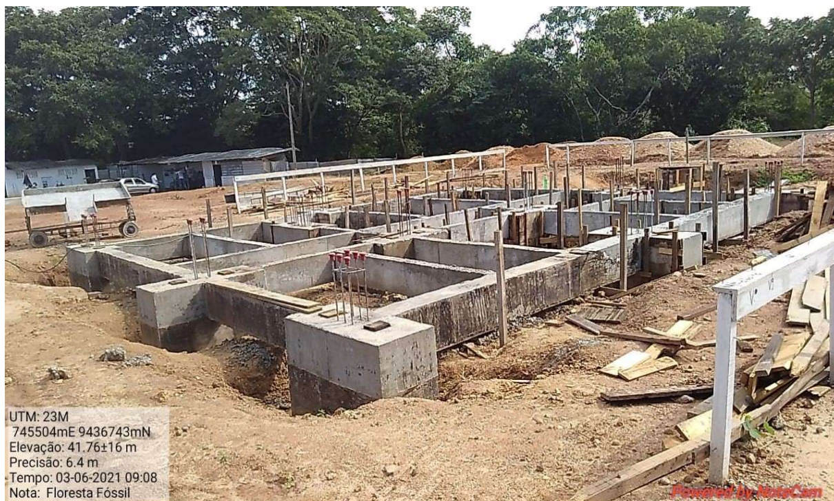
Figura 22 - Obras de terraplanagem para construção do parque Floresta Fóssil de Teresina-PI
