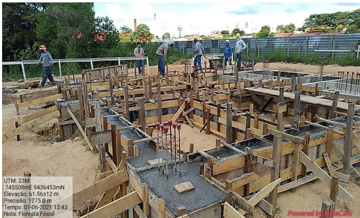
Figura 24 – Espaço com poucos trabalhadores em operação no levantamento de estacas de madeira e cimentação no Parque Floresta Fóssil, em Teresina-PI
