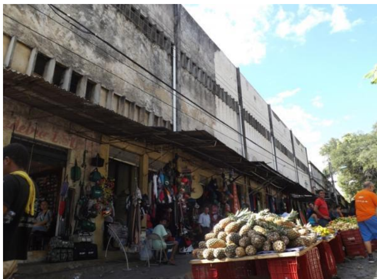
Figura 22: Fachada do mercado São José no ano de 2014
