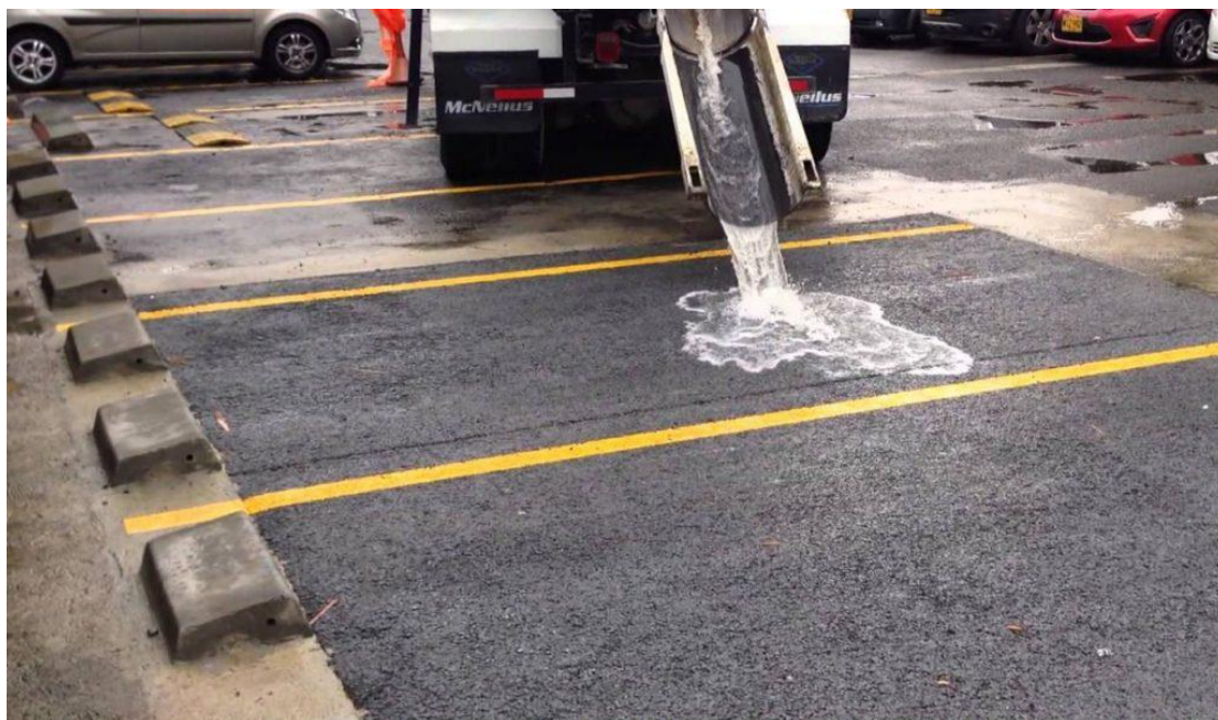
Figura 2 – Exemplo de pavimentos permeáveis.
