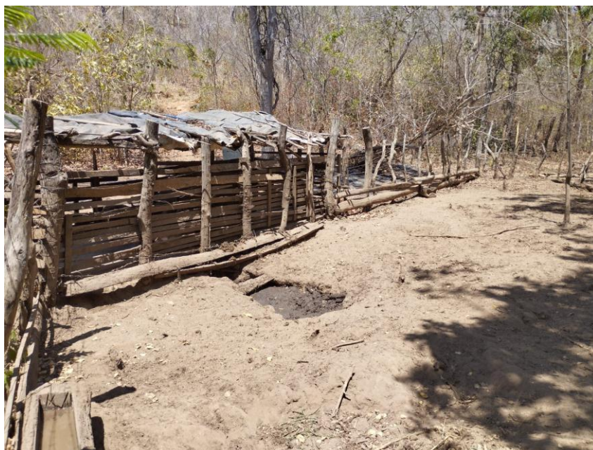
Figura 04: Avaliação das condições das instalações para o alojamento dos suínos.
