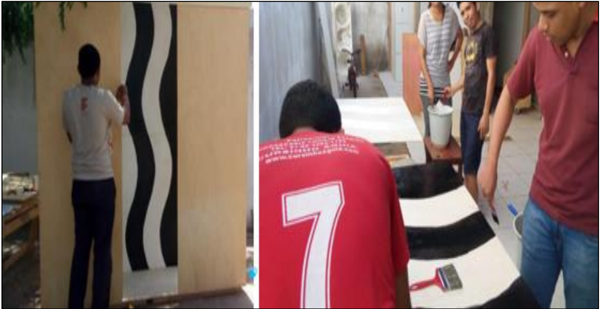
Figura 2 – Confeção do Material concreto Paineis 3D
