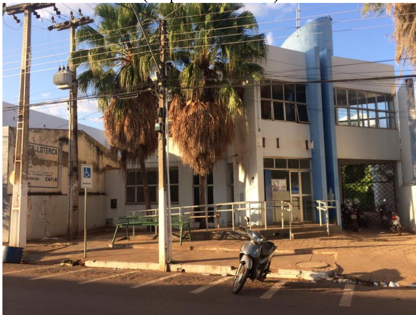
Figura 3: Antigo Prédio da Caixa Econômica Federal situado à Rua Desembargador Amaral (Propriedade Privada)
