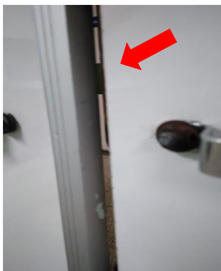
Figura 16: porta fechada com abertura.
