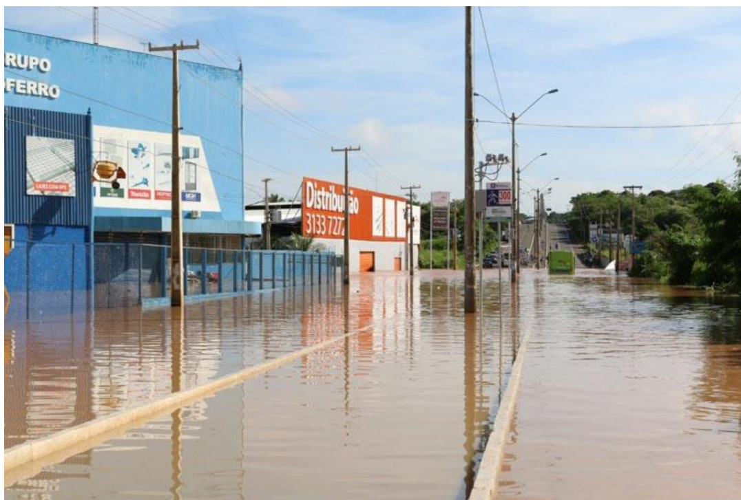
Figura 42: Trecho da Av. Joaquim Nelson totalmente inundado.
