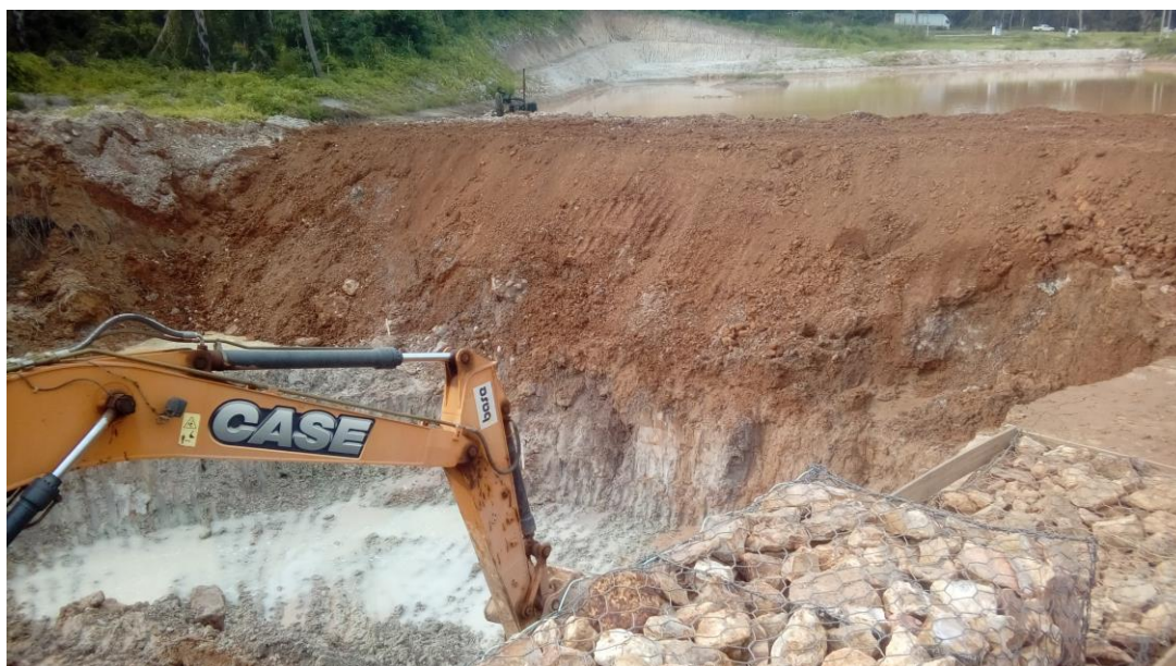
Figura 39: Foto da construção do sistema de dissipador de vazão.
