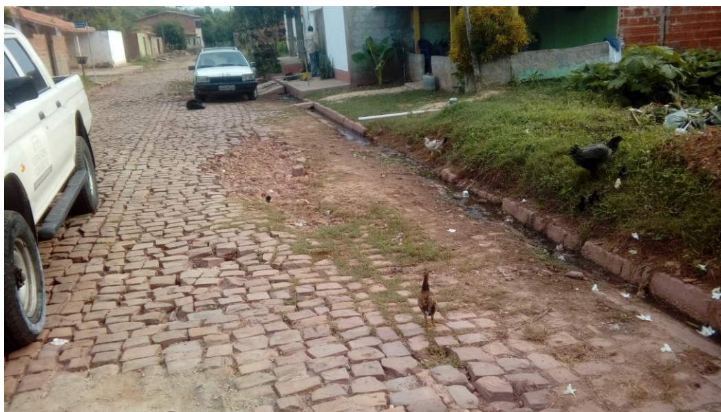
Figura 33: Foto da rua escavada no Bairro Verde Lar.
