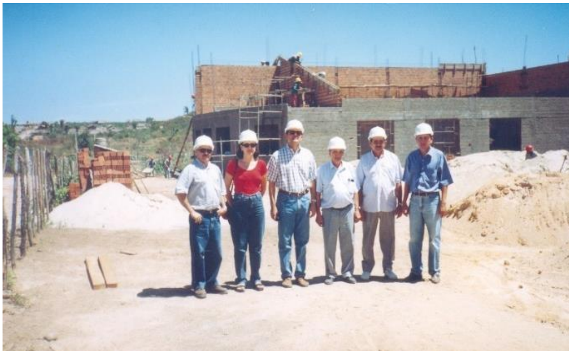
FIGURA 11 – Construção do CACN
