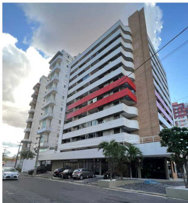
Figura 4 – Edificação de uso misto
