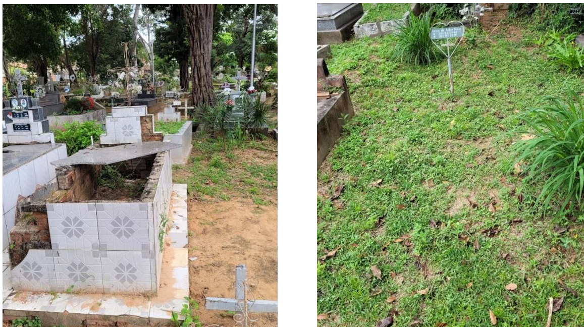
Figura 25.a e 25.b - Jazigo deteriorado (a esquerda) e cova em solo exposto (a direita)
