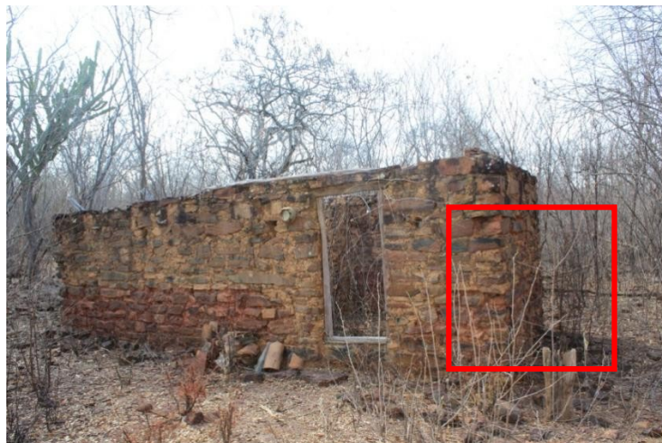
Figura 16 - Casa de Pedra/Zabelê
