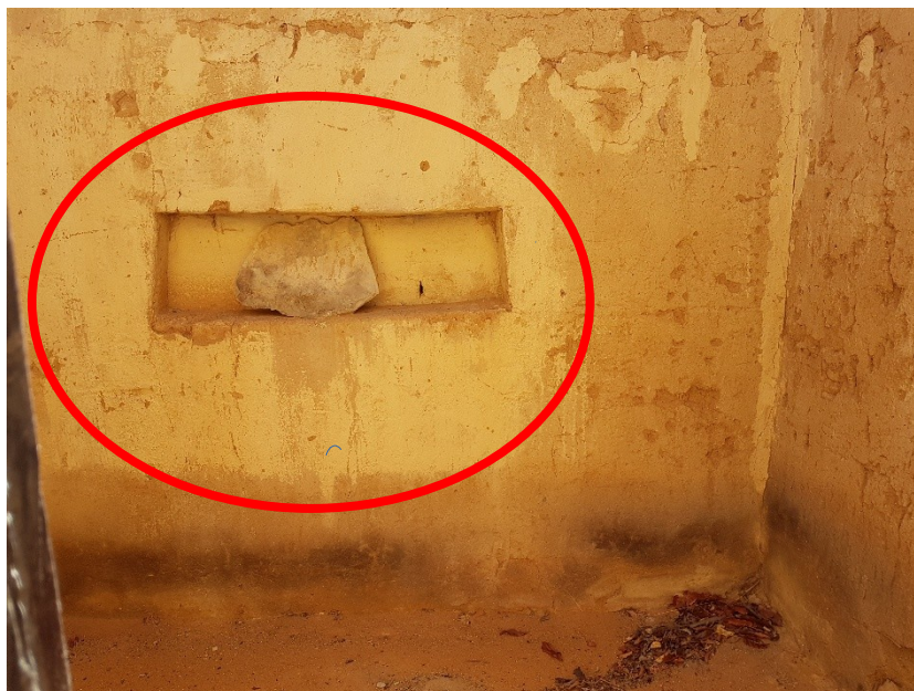
Figura 6 - Armário de cozinha da Fazenda Jurubeba
