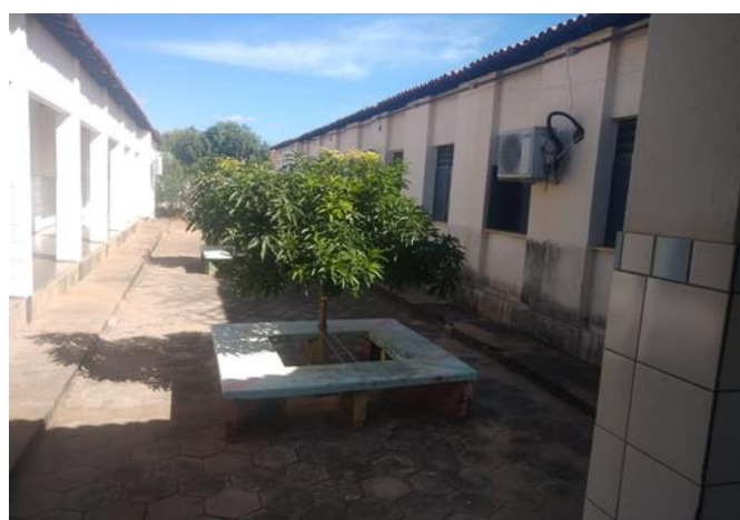
Figura 11: Dependências da escola CETI-Moderna.
