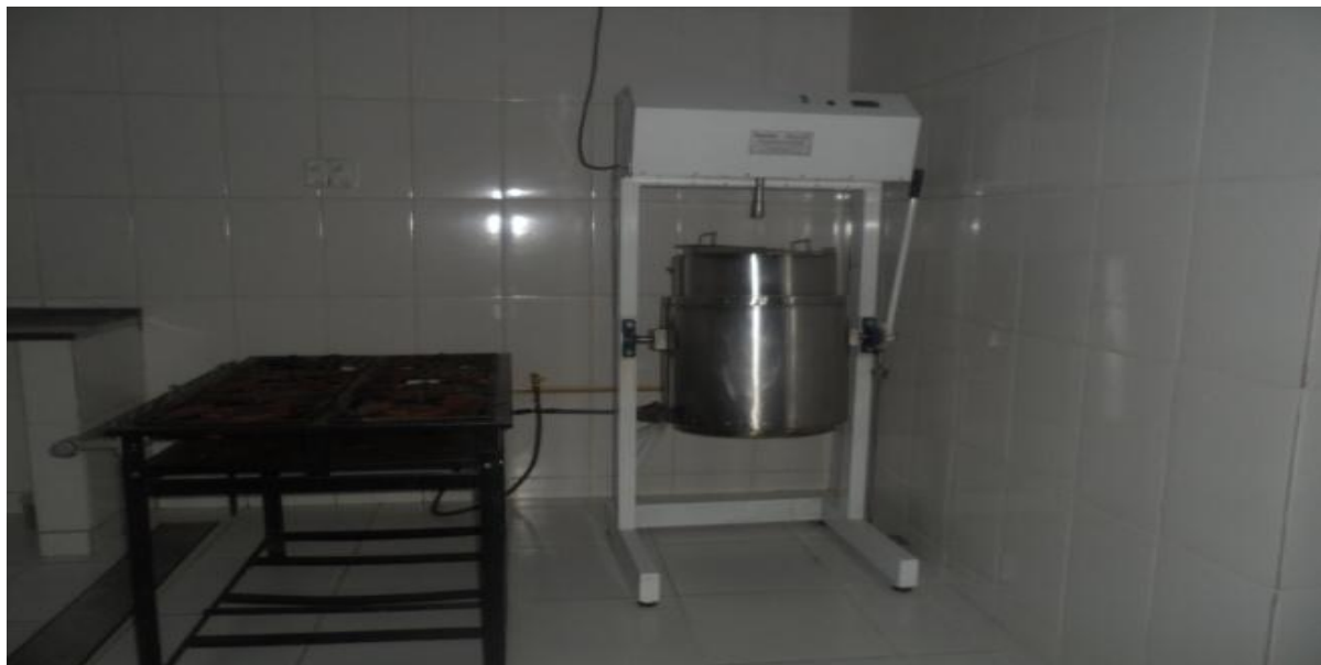
Figura 08 - Estrutura para beneficiamento de fruta, Cooperativa Novo Zabelê
