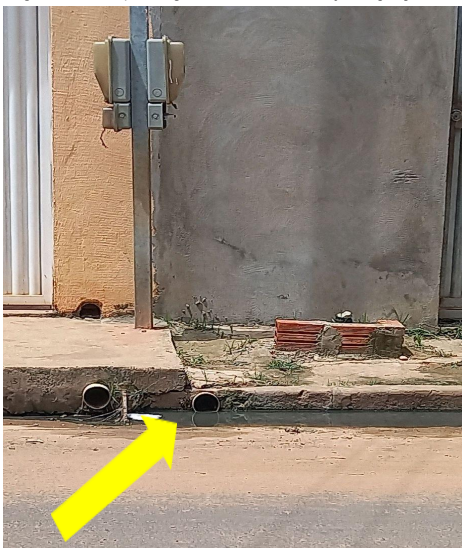
Figura 22: Presença de esgoto a céu aberto nos conjuntos pesquisados.
