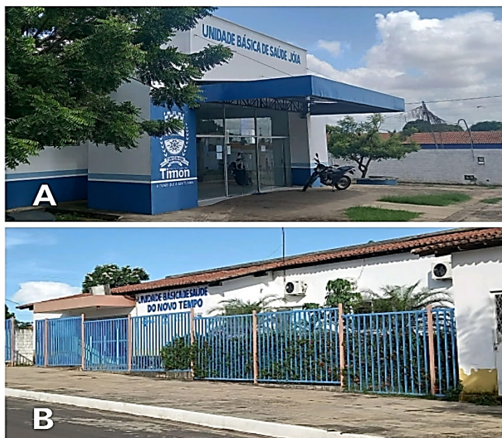
Figura 31: UBS localizada no bairro Jóia (A), UBS localizada no conjunto Novo Tempo (B).
