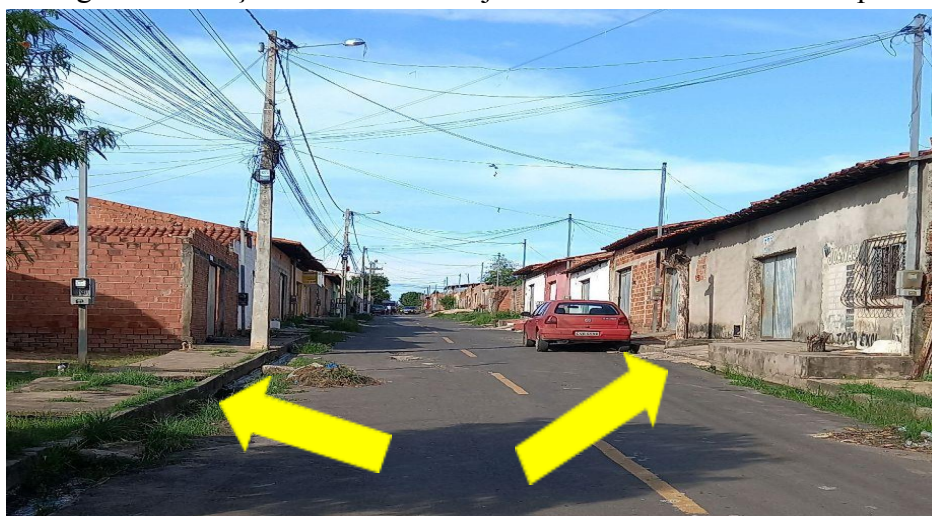
Figura 46: Calçada em rua do conjunto habitacional Novo Tempo.
