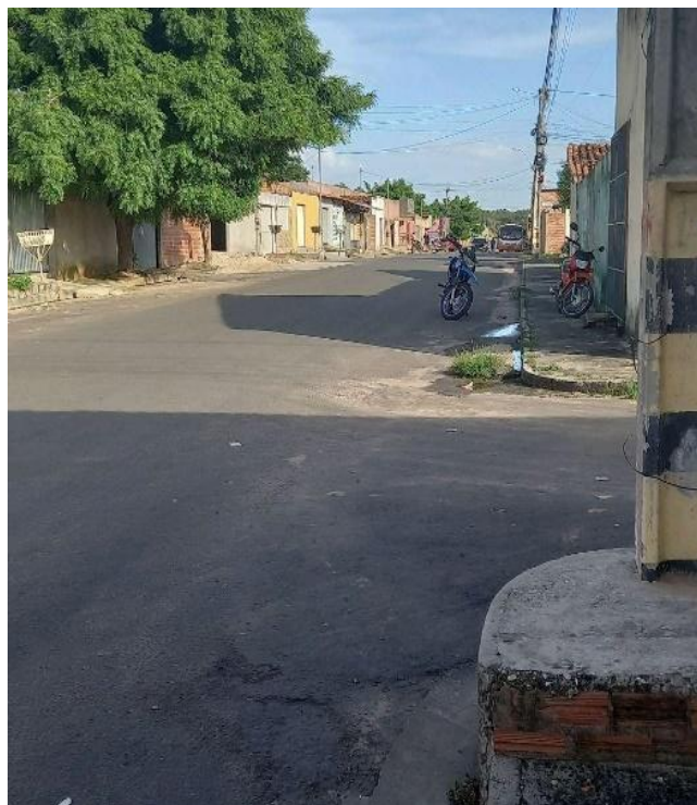
Figura 52: Rua principal (com asfalto) no conjunto habitacional Novo Tempo.
