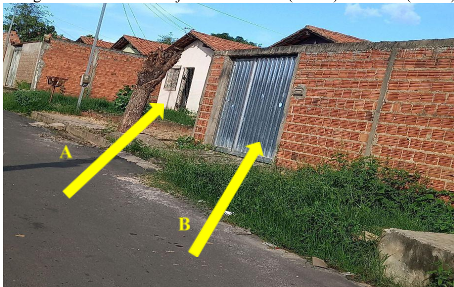
Figura 16: Casas dos conjuntos sem muro (seta A) e murada (seta B).
