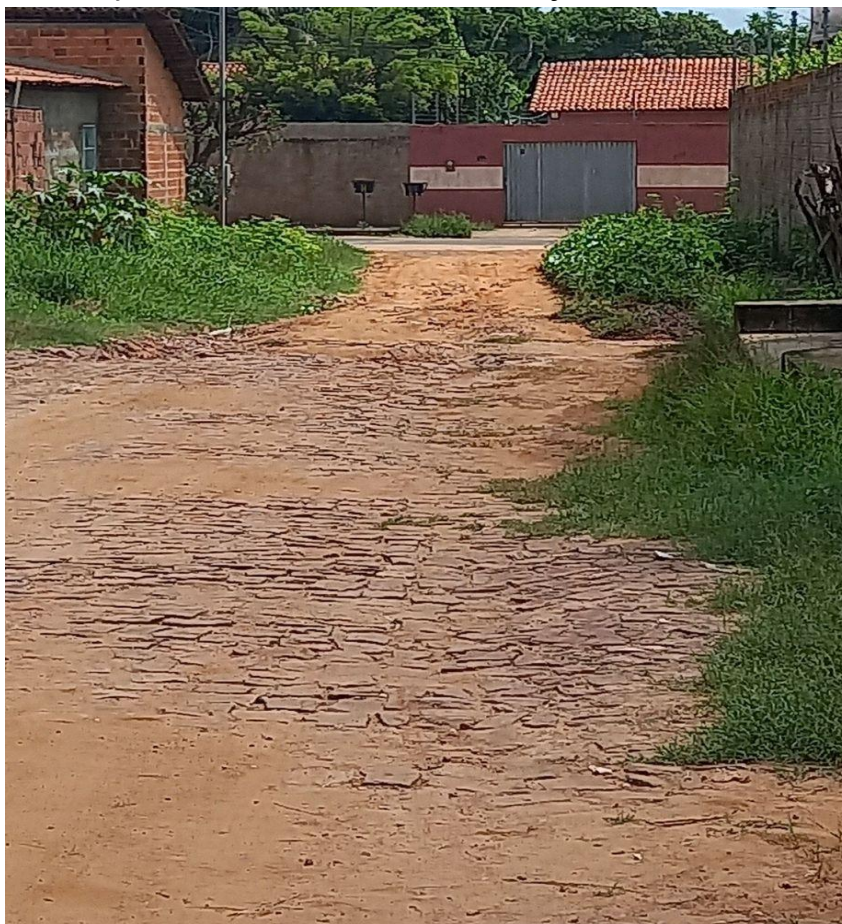
Figura 50: Calçamento em via secundária do conjunto habitacional Novo Jóia.
