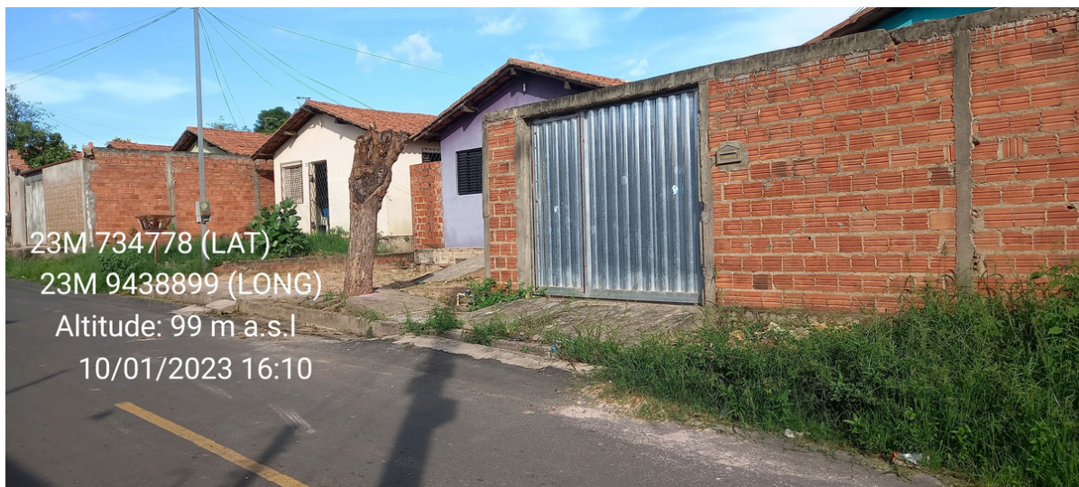
Figura 5 - Casas com intervenções estruturais no terreno (construção de muros) em conjunto Novo Tempo. Fonte: dados da pesquisa (2023).
