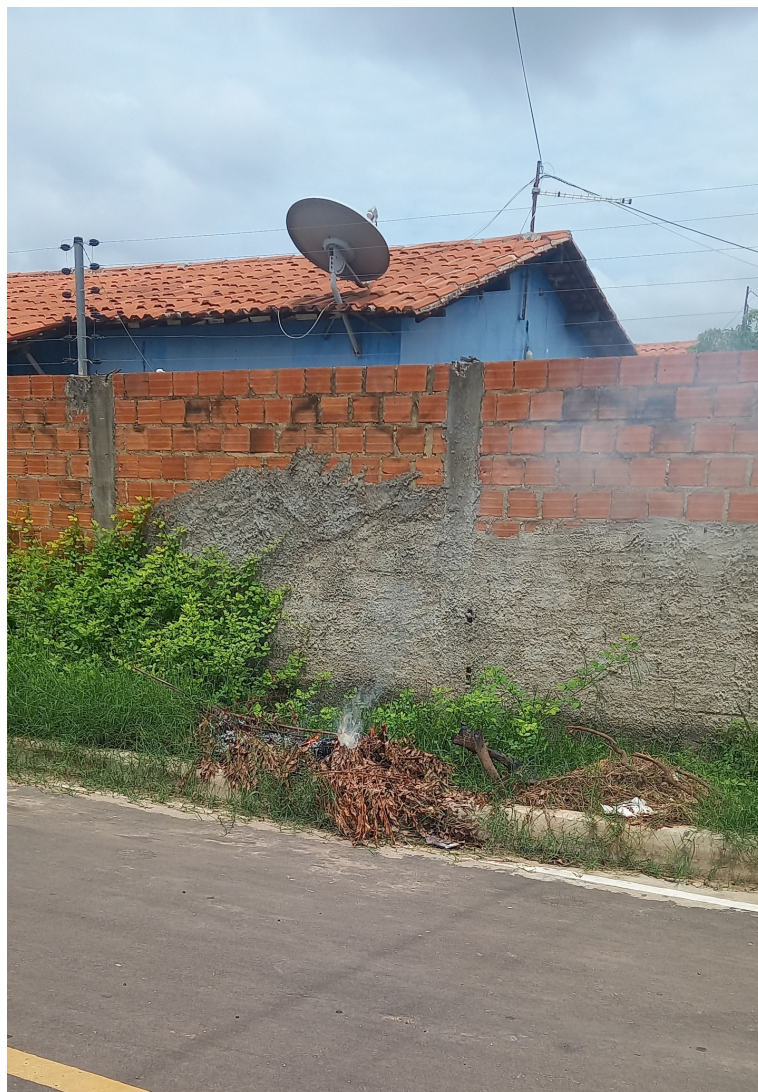
Figura 6 - Queima de resíduos sólidos em via pública e presença de vegetação no entorno de residências no conjunto Novo Joia. Fonte: dados da pesquisa (2023).
