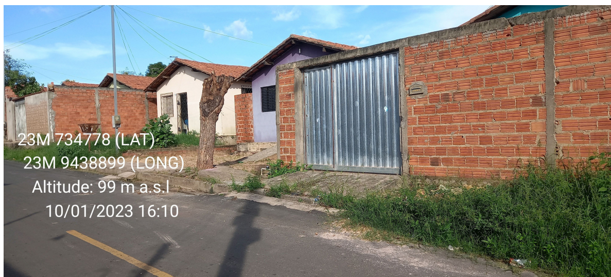
Figura 3 - Casas com intervenções estruturais no terreno (construção de muros) em conjunto Novo Tempo.
