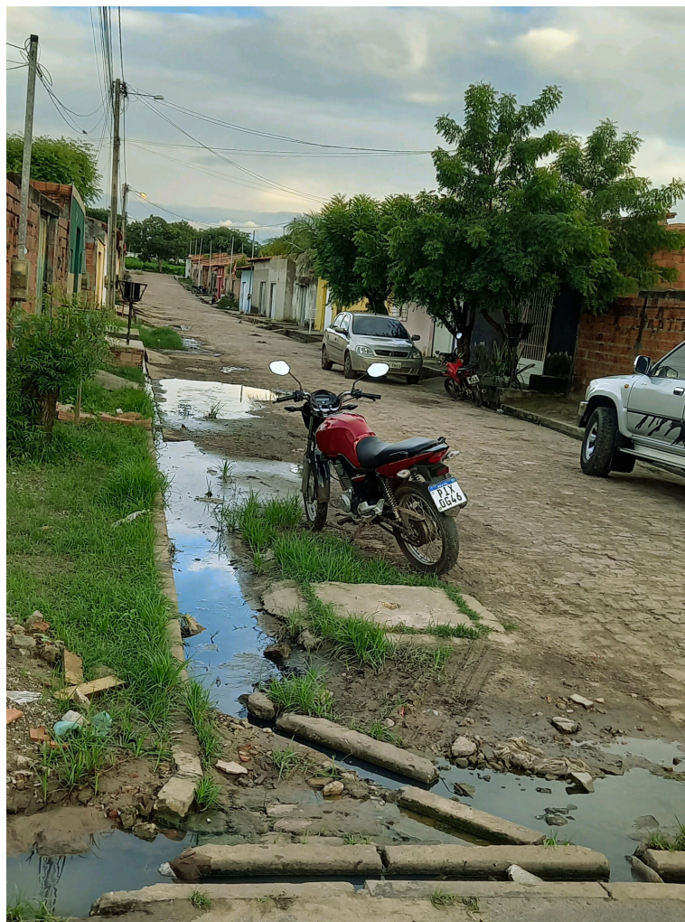
Figura 11 - Rua secundária (em péssimas condições infra-estruturais) do conjunto Padre Delfino.
