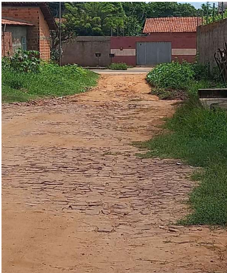
Figura 50: Calçamento em via secundária do conjunto habitacional Novo Jóia.
