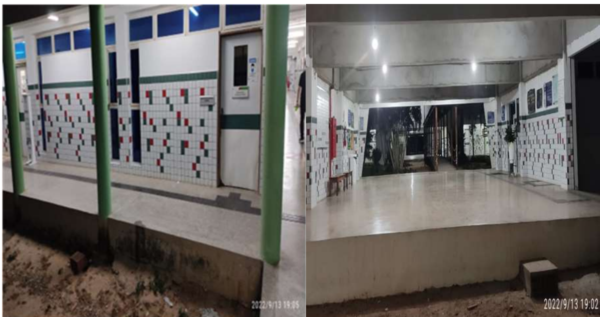
Figura 17 – Riscos de acidentes no IFPI/ Campus Parnaíba em ambientes diversos
