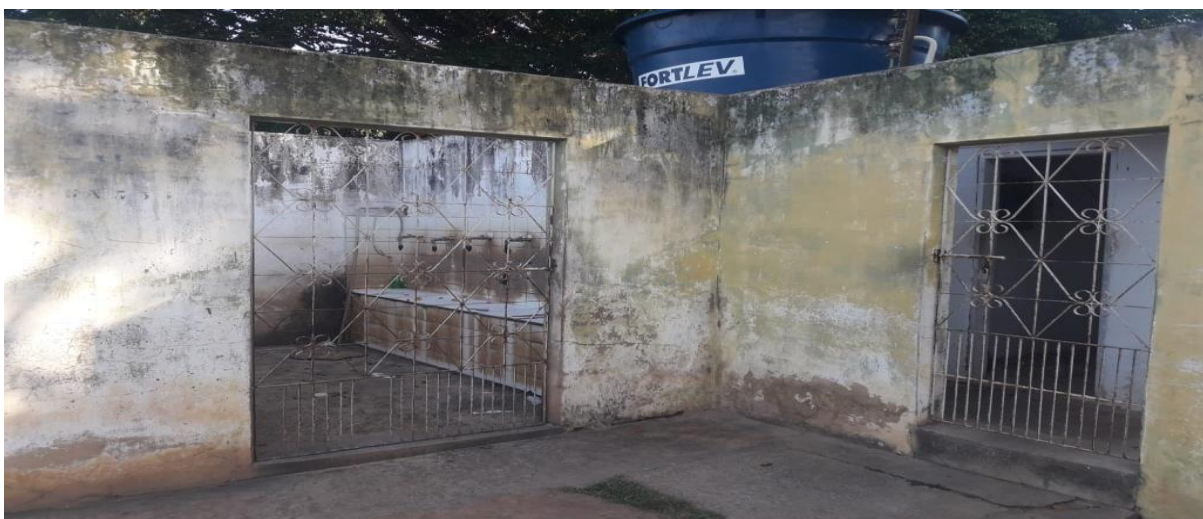
Figura 05. Chafariz do bairro Vila Kolping. Fonte: Acervo pessoal, 2019
