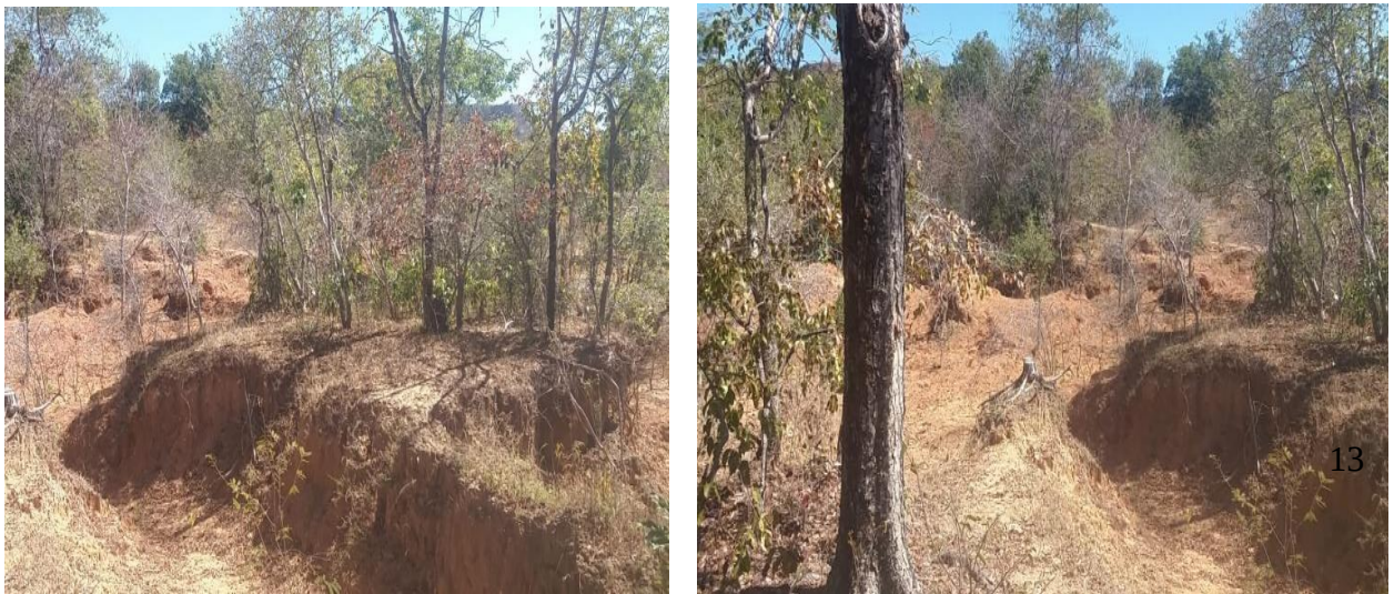
Figura 4 - Voçorocas da barragem dos Cocos.
