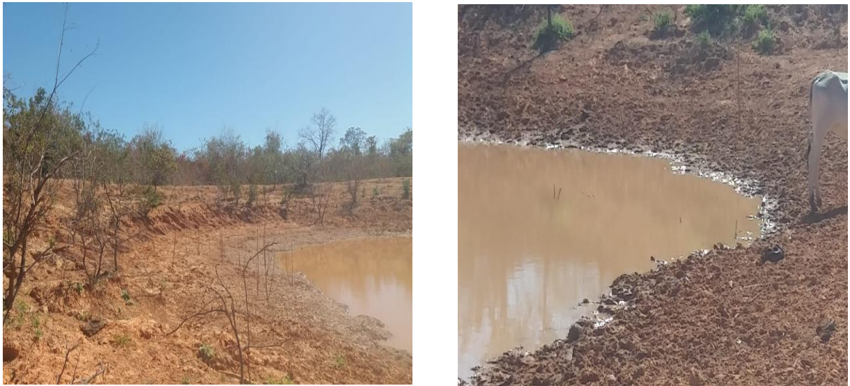
Figura 2-.Compactação do solo da barragem de Cocos.
