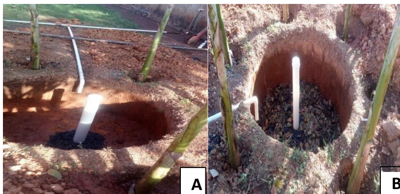
Figura 4. Finalização da implantação do método círculo de bananeiras.
