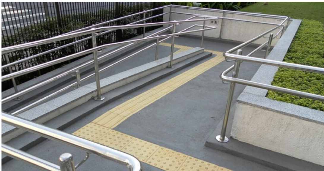
Figura 1 – Rampa com piso tátil
